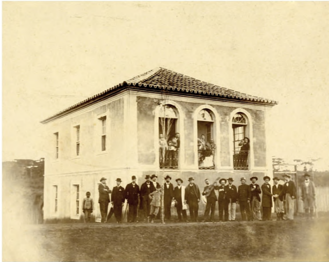
Aula Pública na Zona Caipora, atual Bairro Nossa Senhora de Lourdes, c.1899
