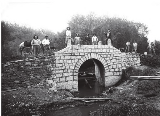
Ponte Cel. Tancredo Feijó, conhecida como Ponte Negra no Bairro Santa Catarina, 1909
