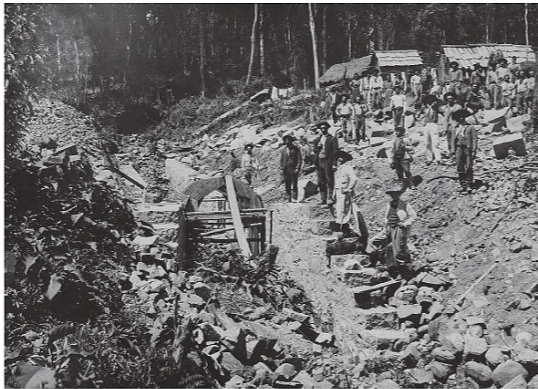
Construção da estrada de ferro, 1908
