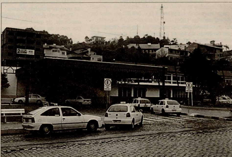
Obras na Rodoviária facilitam o acesso dos usuários ao terminal de passageiros
