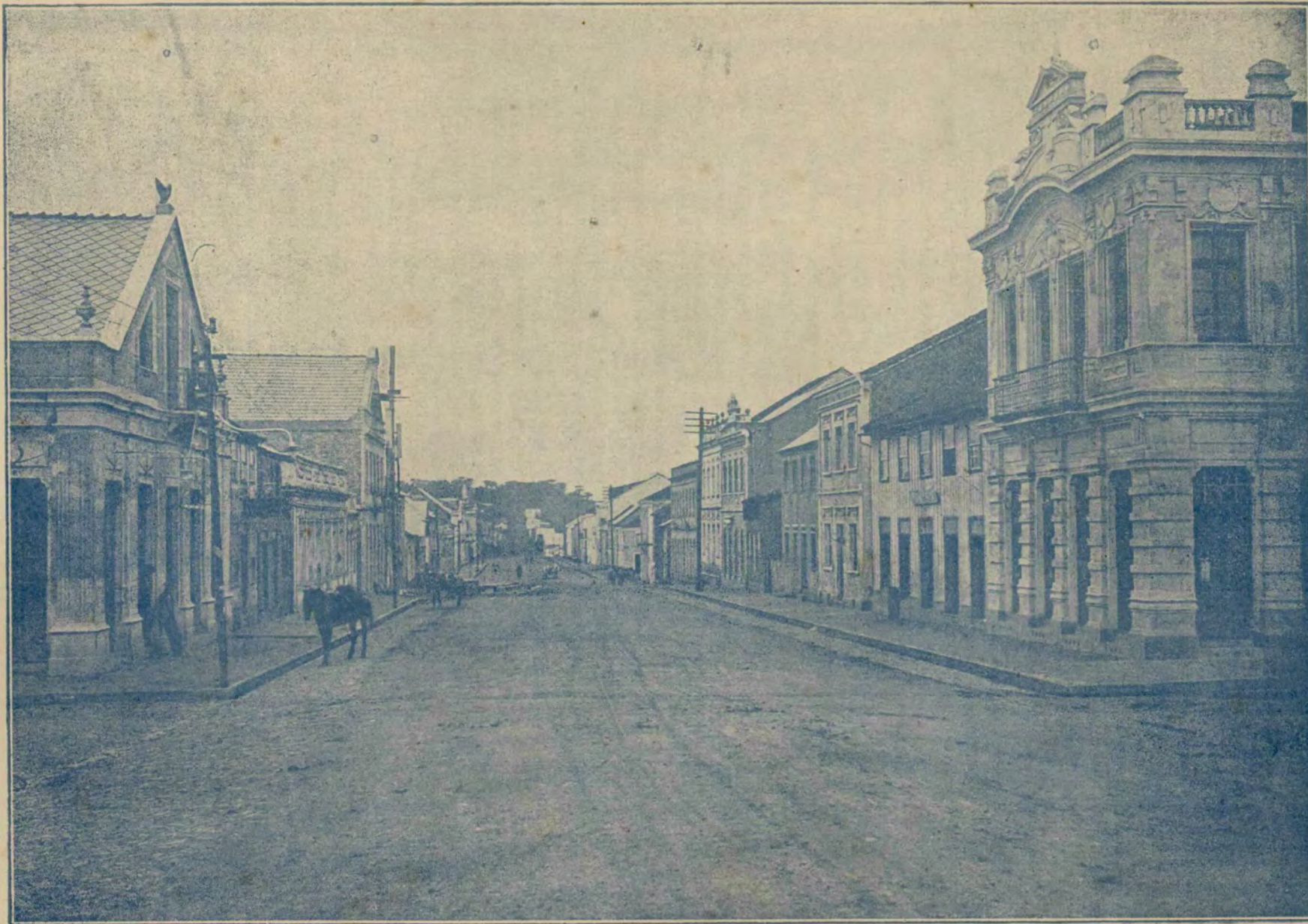
Trecho da rua Julio de Castilhos, nivelado e macadamizado em 1914.
