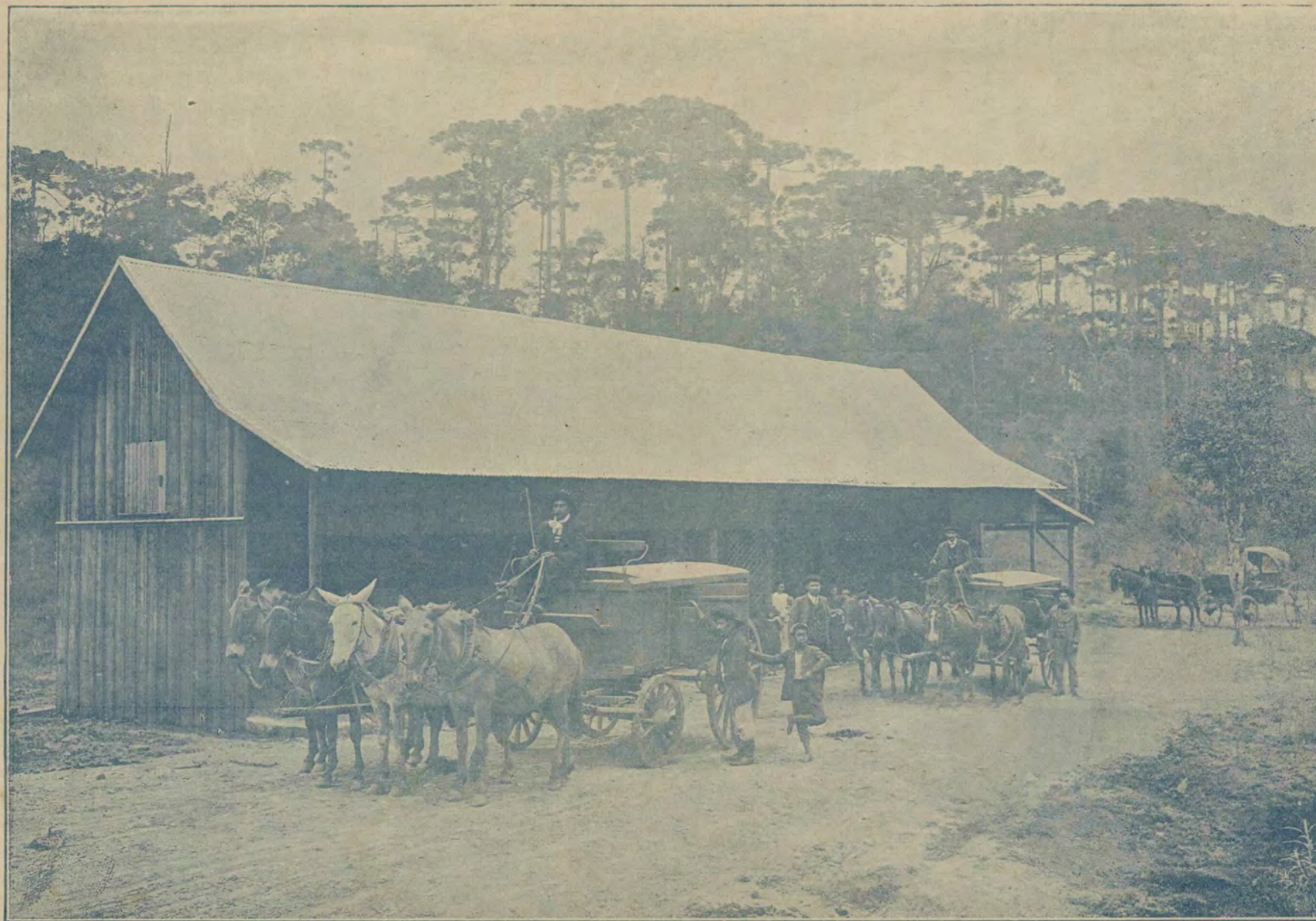
Galpão para o abrigo de carros e depósito de cubos para o serviço de remoção de matérias feças.
