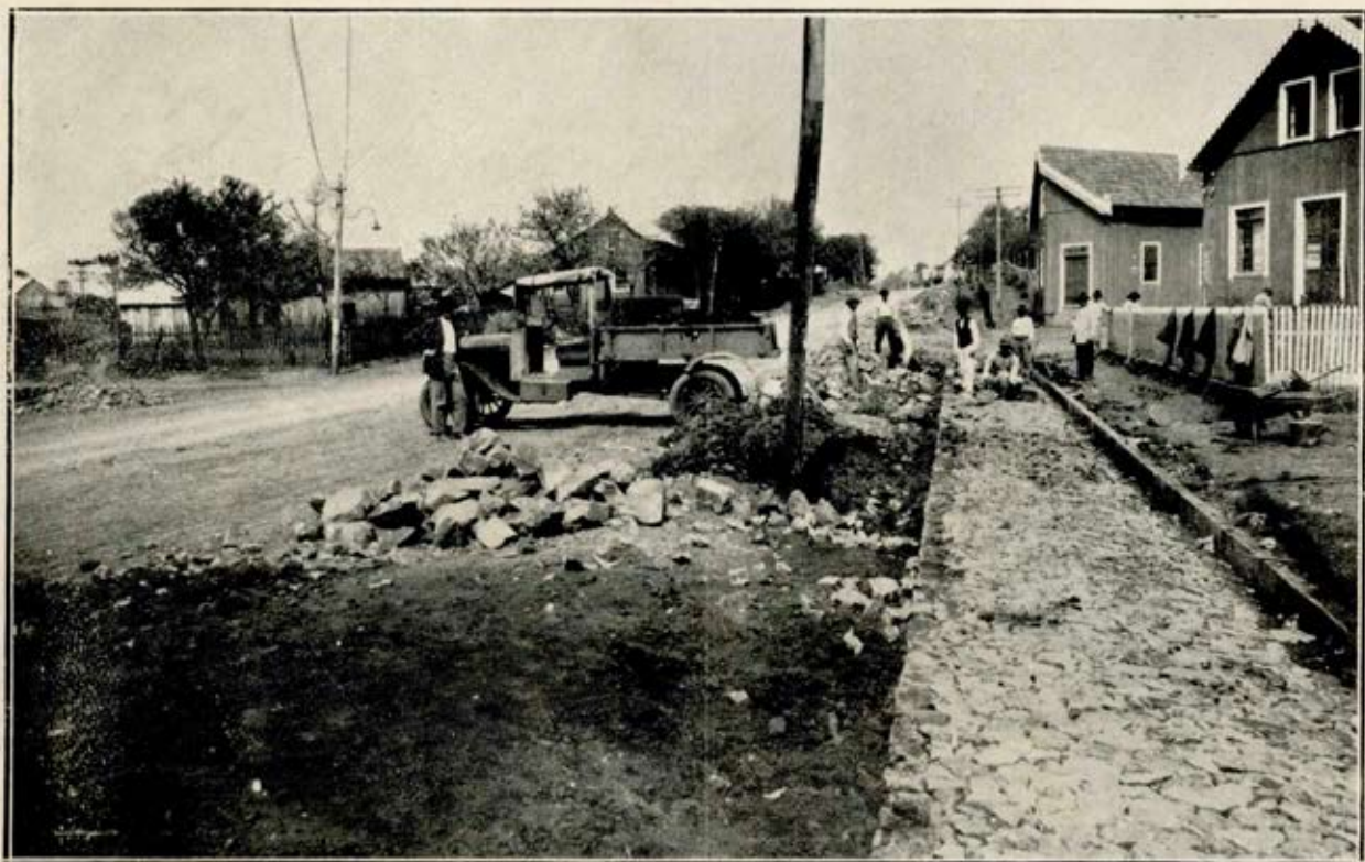
Assentamento de cordão e sargeta na avenida Rio Branco.
