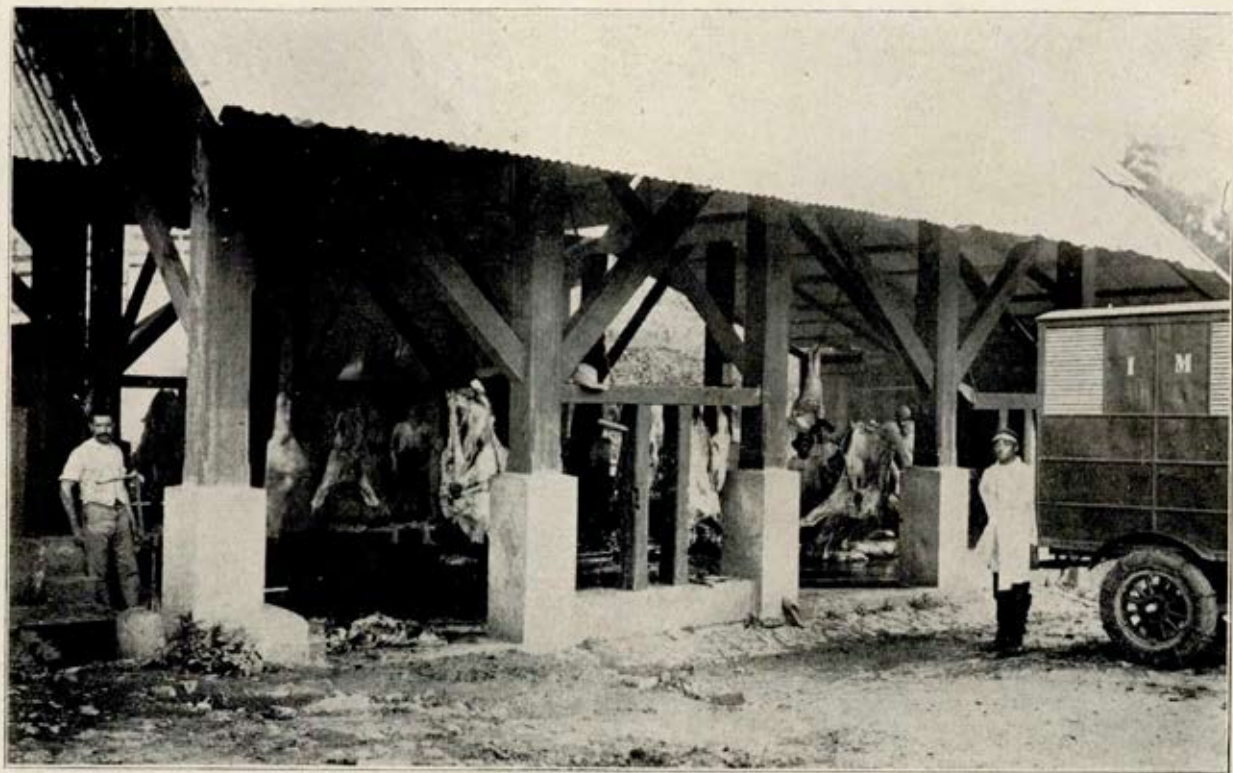
O matadouro municipal depois de reformado e o caminhão para o transporte da carne.
