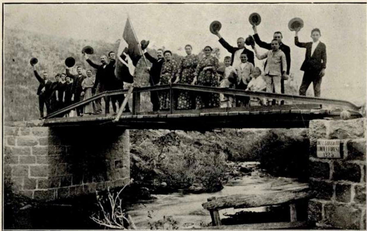
Ponte sobre o Rio Buratti construida com trilhos.
