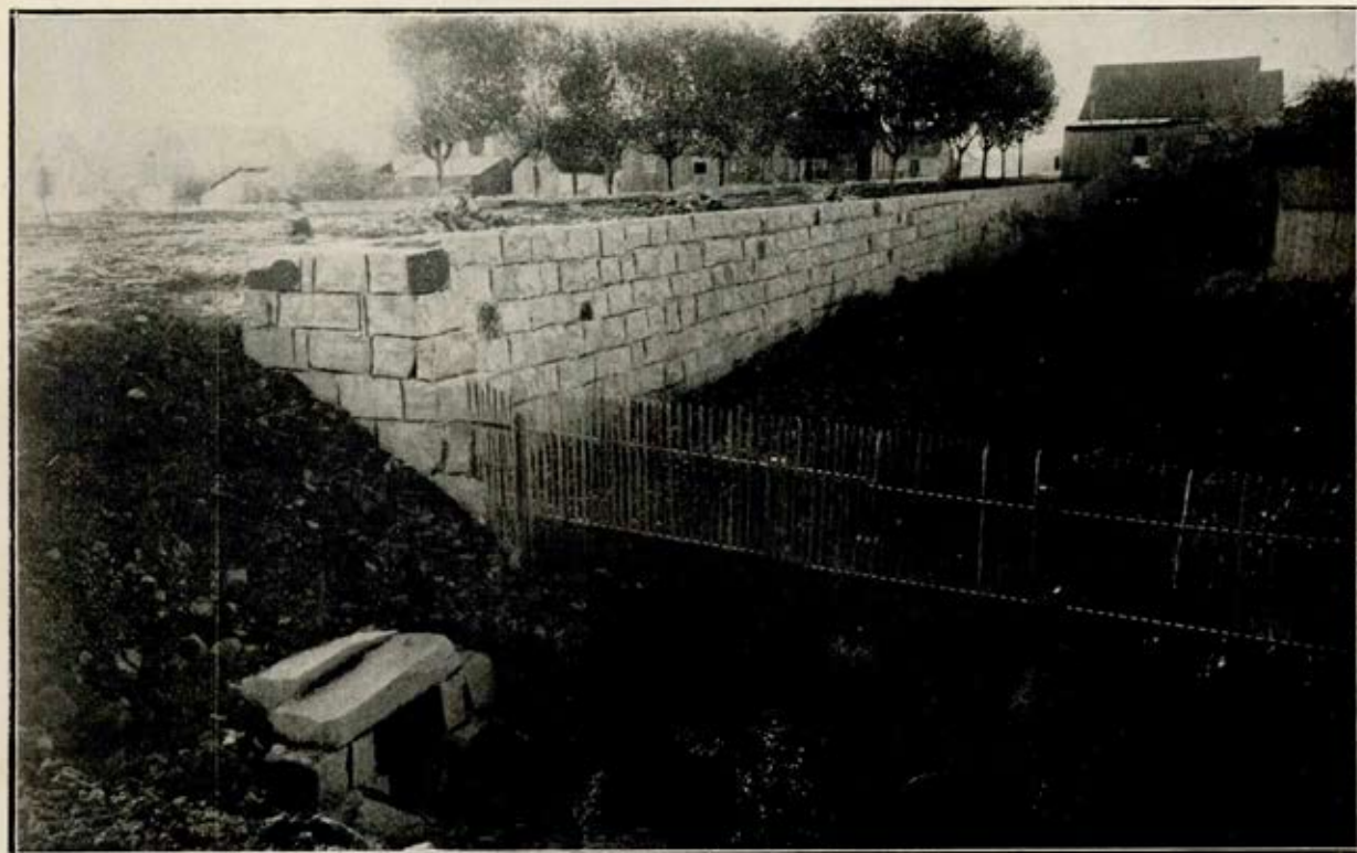
Muros de arrimo na rua Coronel Flores.
