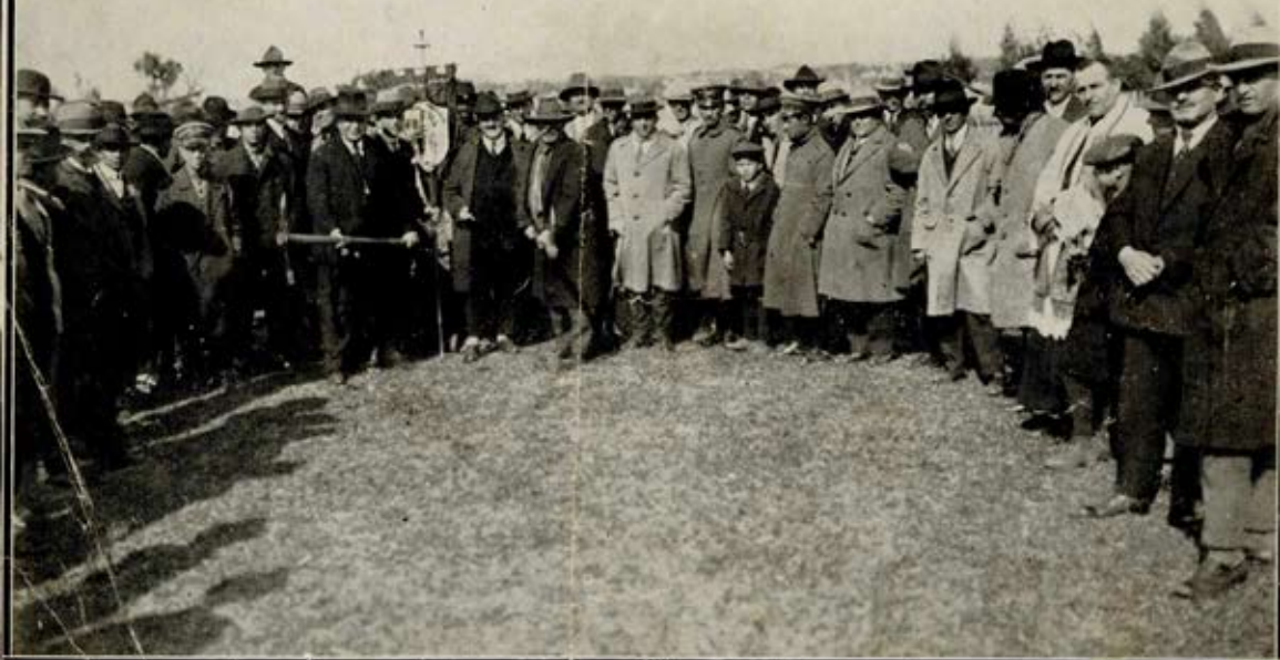
HYDRAULICA MUNICIPAL — O primeiro golpe de picão. 7-9-1927.
