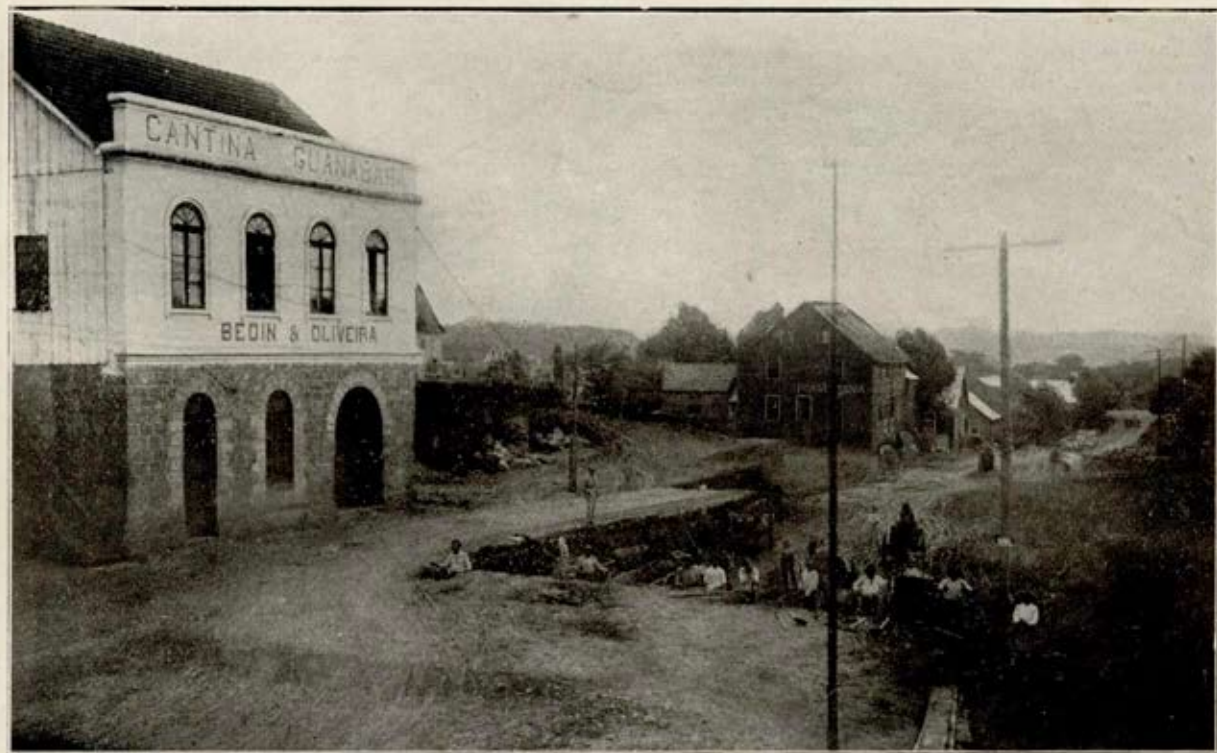
Trabalhos de desaterro na rua Coronel Flores.
