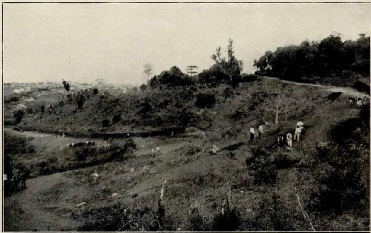
Construcção da estrada que vae ao Hotel Menegotto, actualmente rua Dr. Octavio Rocha.
