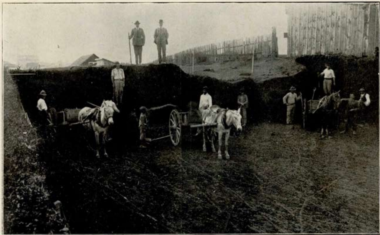
Abertura da rua de acesso ao Parque do cincoentenário.
