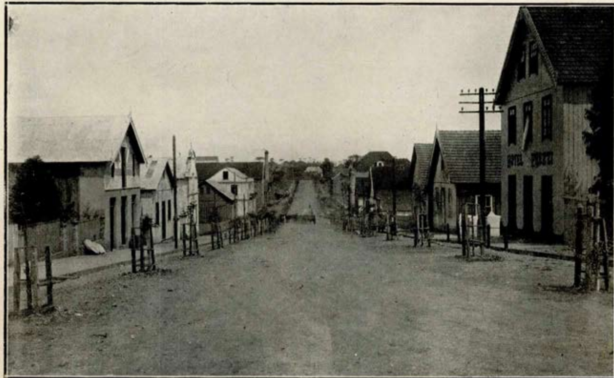
Um trecho da rua Andrade Pinto depois de terminada, macadamizada e arborizada com typhas.
