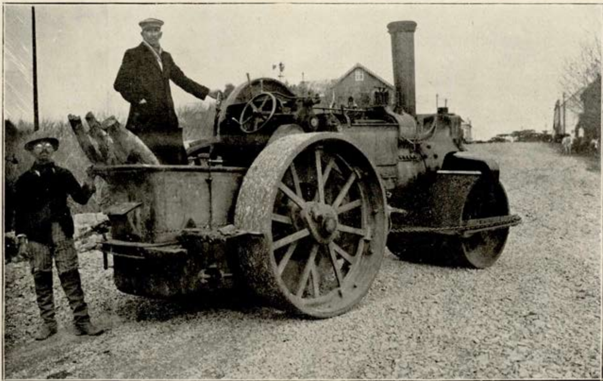
Ralo-compressor para o acabamento da macadamização das ruas.
