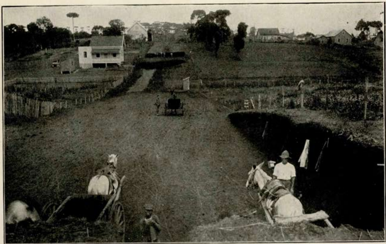
O movimento de terra que se torna necessario realizar para a abertura de ruas na cidade — Avenida Italia.
