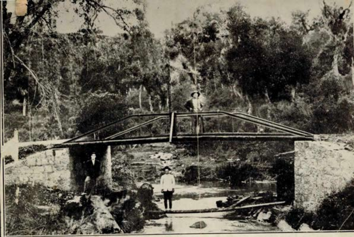
Ponte na Linha Alencastro (Nova Vicenza) com trilhos de ferro.
