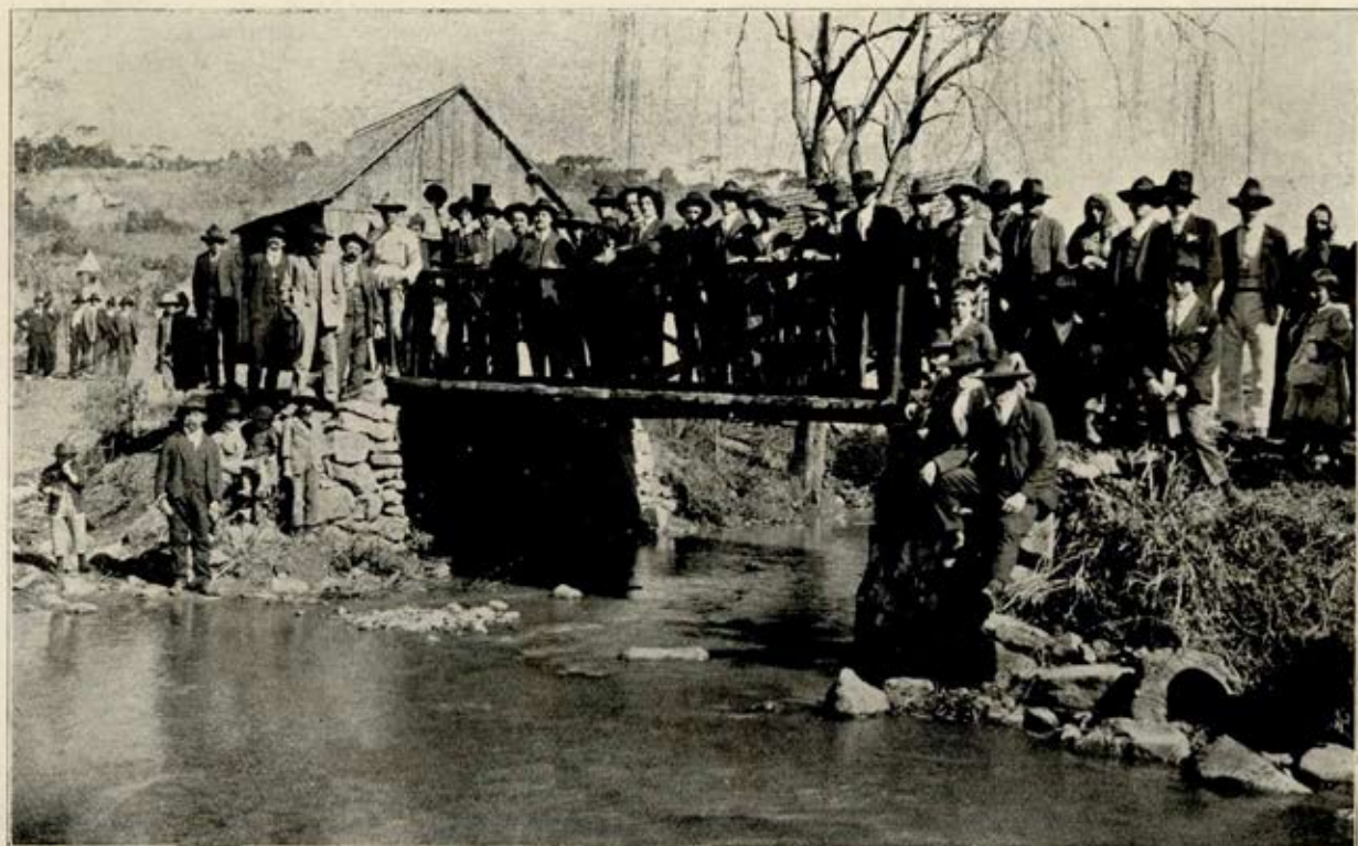
Pontilhão de trilhos sobre o rio do Quarenta.
