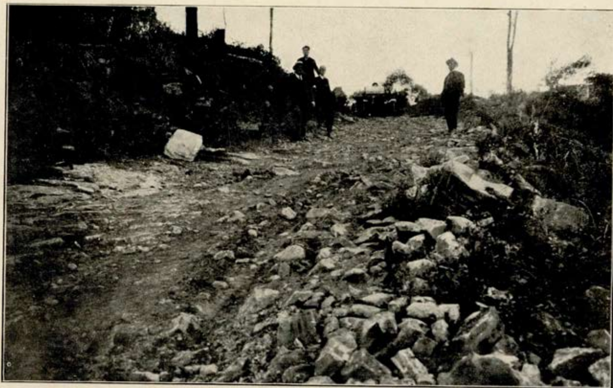
Estrada S. Marcos - Caxias (Potreiro redondo) antes dos trabalhos de reconstrucção.
