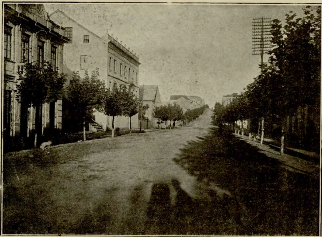
O mesmo trecho da rua Julio de Castilhos, visto na photographia anterior. Aspecto actual, vendo-se, á esquerda, o edificio do Hospital N.ª S.ª de Pompeia. Photographia tirada de Oeste para Leste
