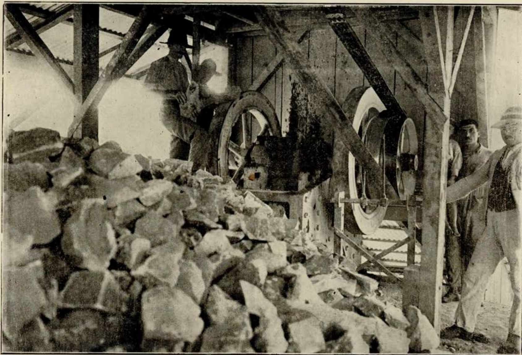
Vista da nova britadeira "Gigante"
