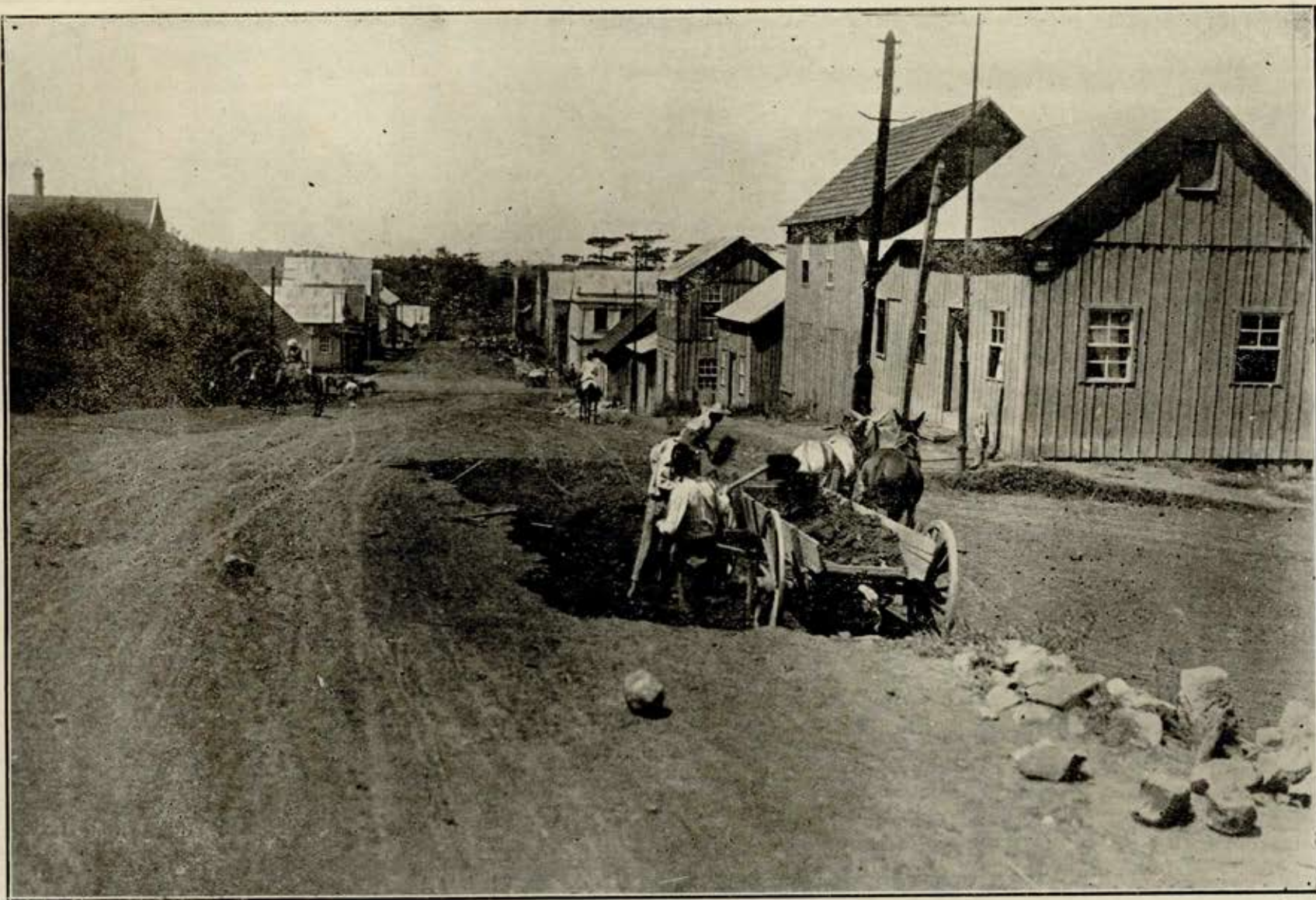
Nivelamento na Rua Marechal Floriano
