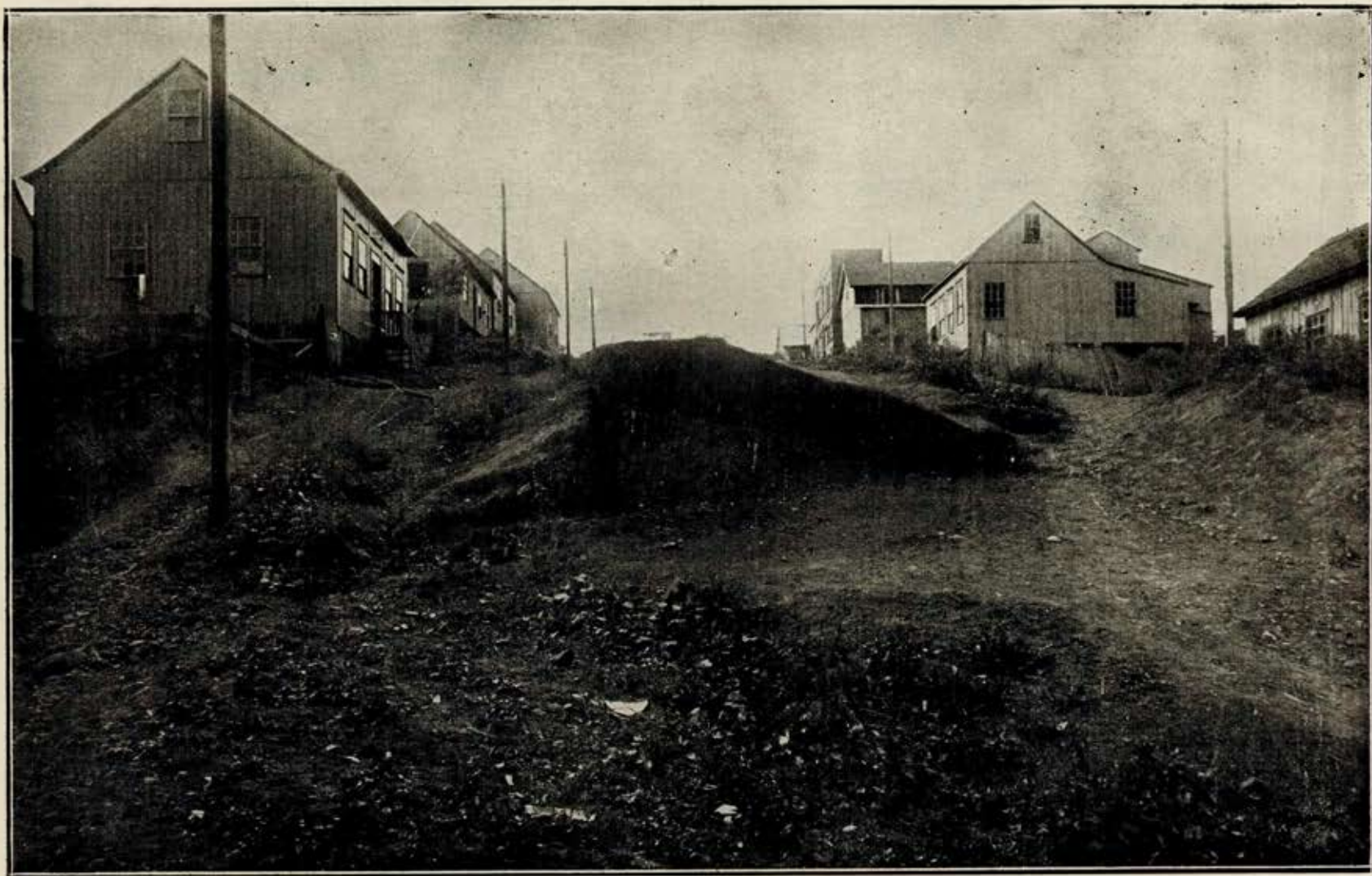
Rua Andrade Pinto (entre as Ruas Garibaldi e Visconde de Pelotas), antes dos trabalhos
