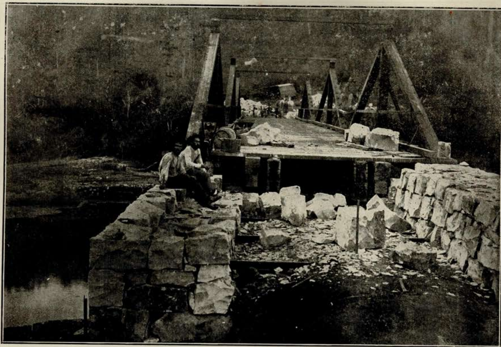
Ponte sobre o "São Marcos" (reconstrução do encontro)
