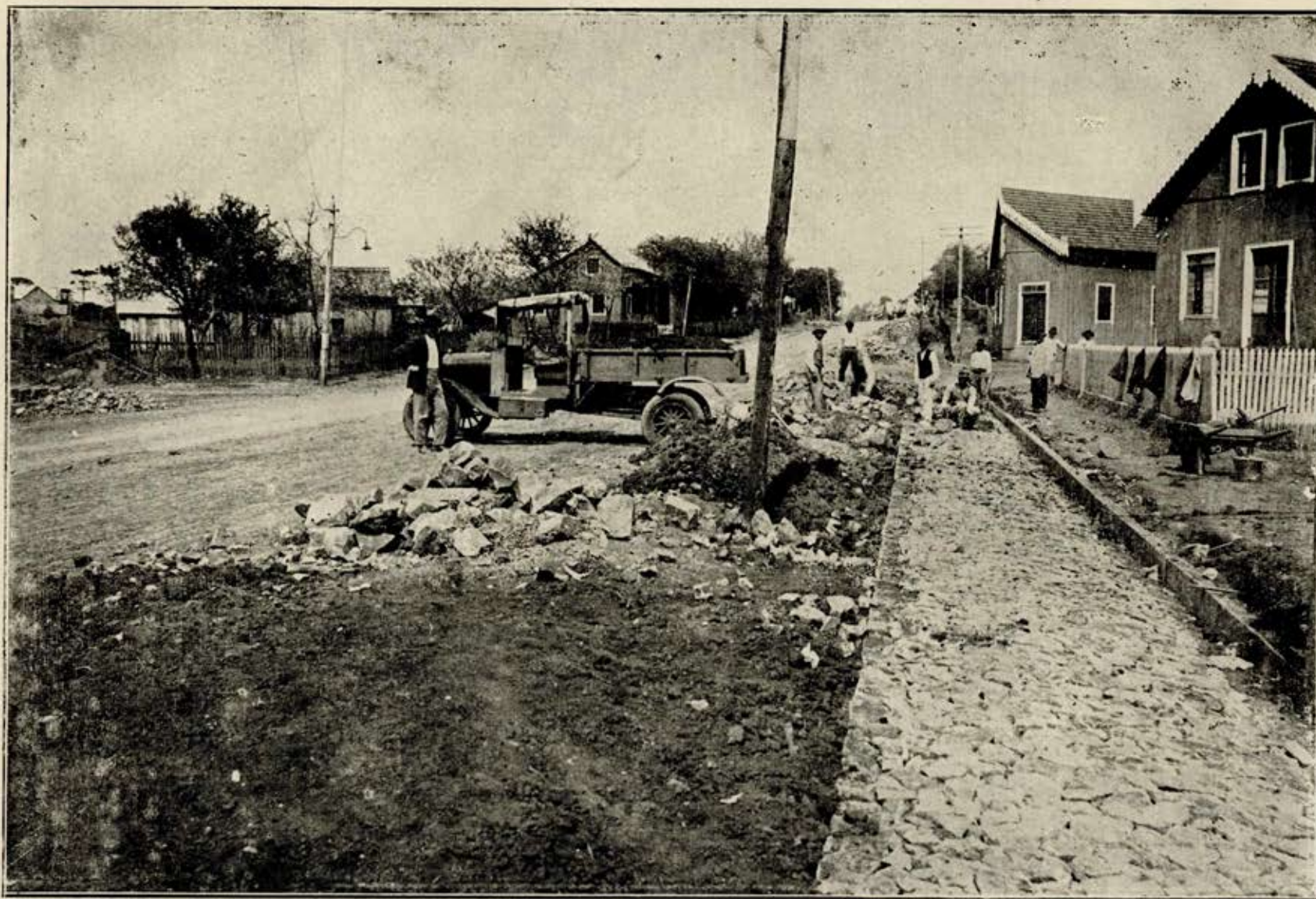
Avenida Rio Branco — assentamento de cordões
