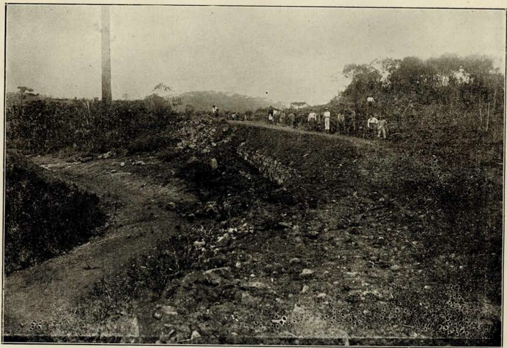
Melhoramentos na estrada Caxias — S. Marcos (construção de variante)
