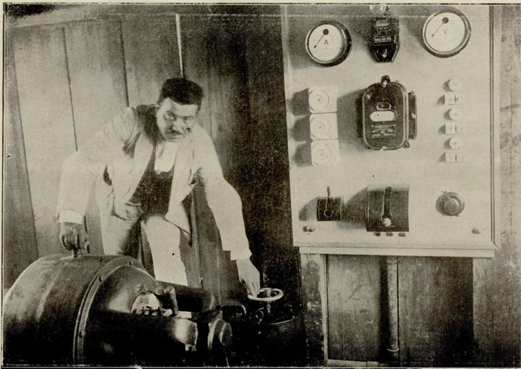
Motor electrico que acciona a nova britadeira "Gigante" e quadro relativo
