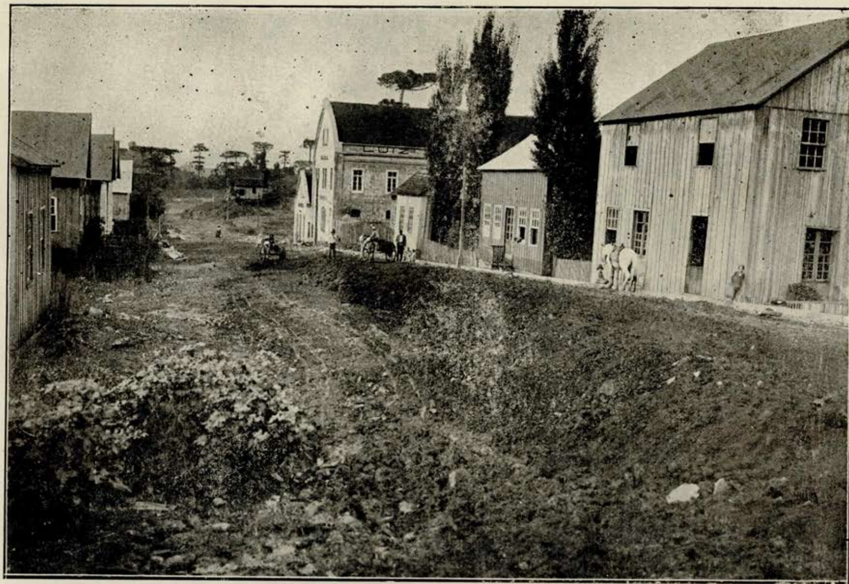
Nivelamento na Rua Marechal Floriano
