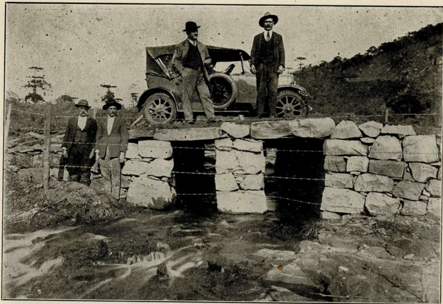
Melhoramentos na estrada Caxias — S. Marcos (construção de boeiro)
