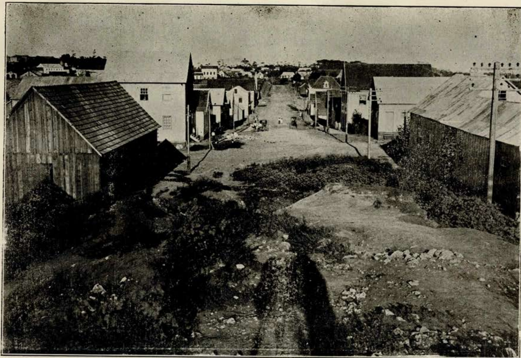
Rua Andrade Pinto (entre as Ruas Garibaldi e Visconde de Pelotas), antes dos trabalhos
