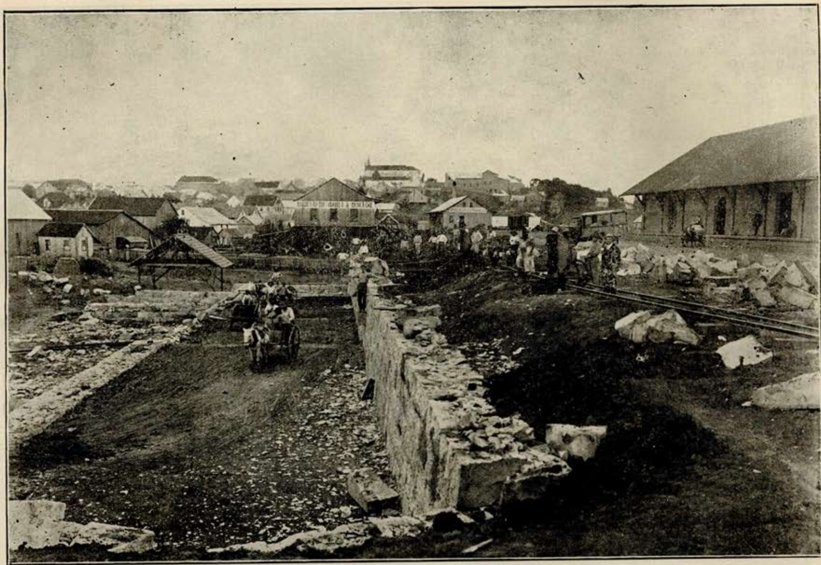
Aterro na plataforma da Viação Ferrea
