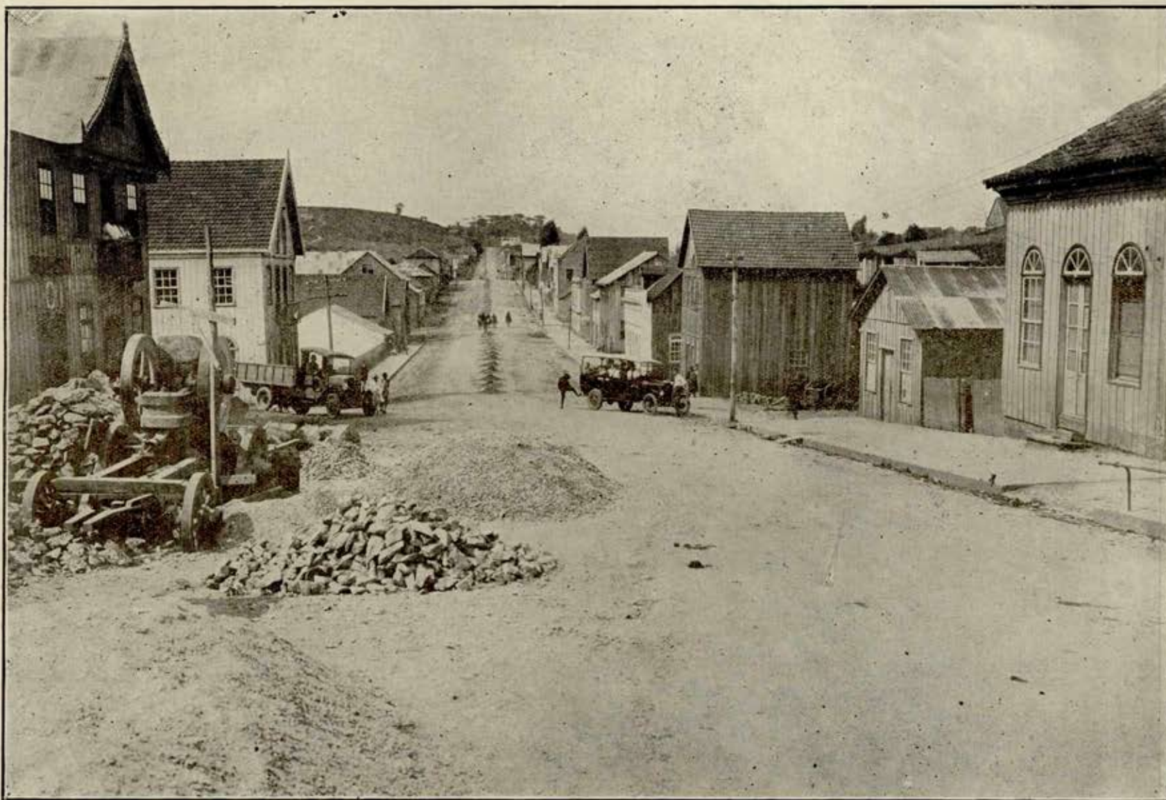
Rua Julio de Castilhos — Macadamização e preparação de covas para arborização
