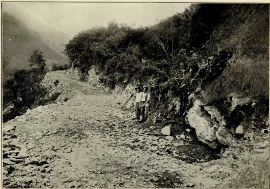
ESTRADA DO PIAHY — Trecho nas proximidades da Ponte do Caravaggio.
