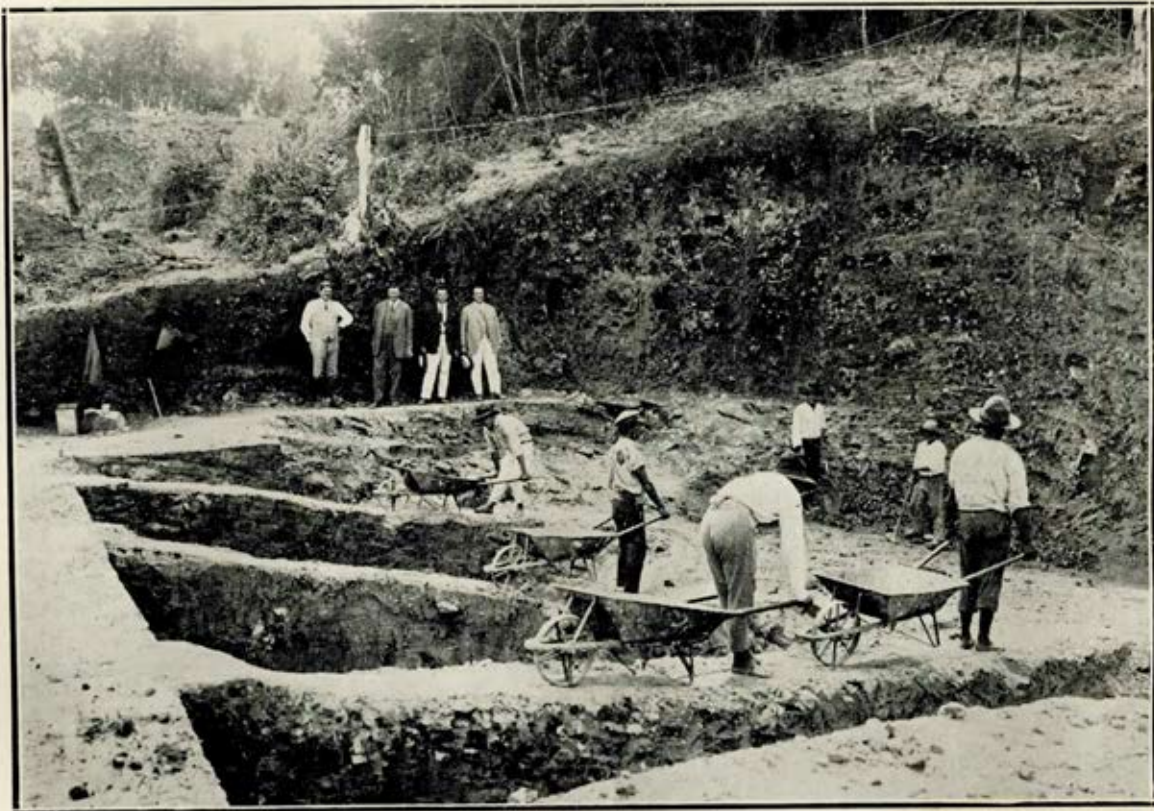
HYDRAULICA MUNICIPAL — Início dos trabalhos no Reservatório N.º 2.
