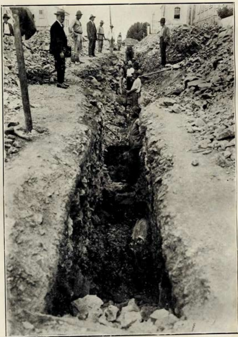
Excavação em rocha para assentamento da linha de distribuição na cidade.
