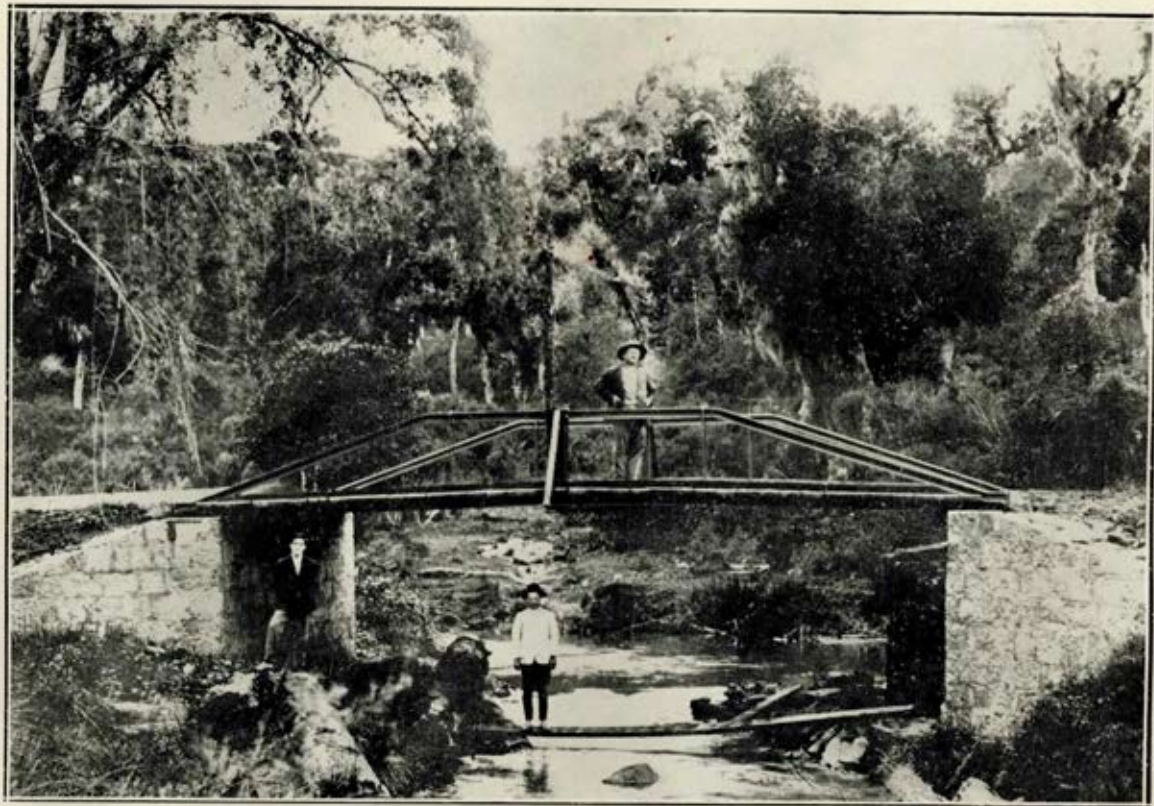
Ponte na Linha Alencastro (Nova Vicenza) com trilhos de ferro.
