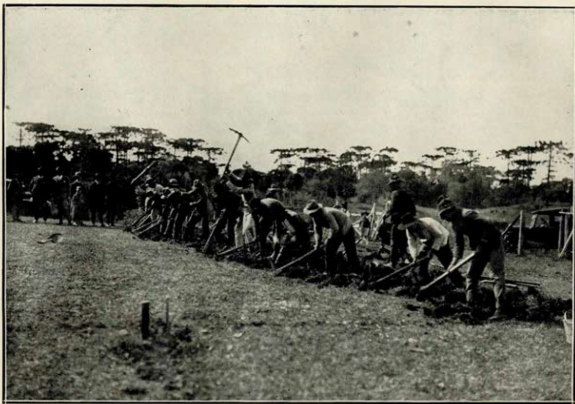
Início dos trabalhos no local do Reservatorio N.º 1 — Casa dos filtros, tanques de decantação e casa do mechanico.
