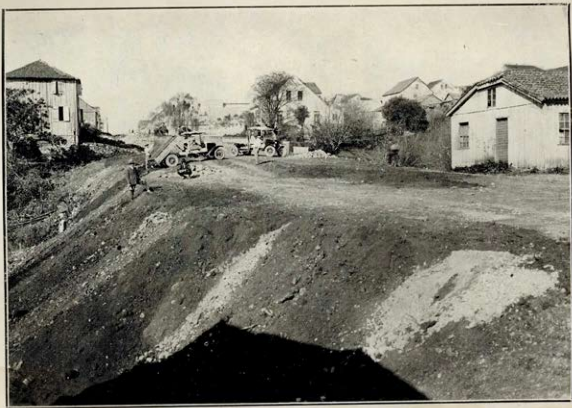
RUA PINHEIRO MACHADO — Aproveitamento nas ruas, do desaterro da Praça Dante.
