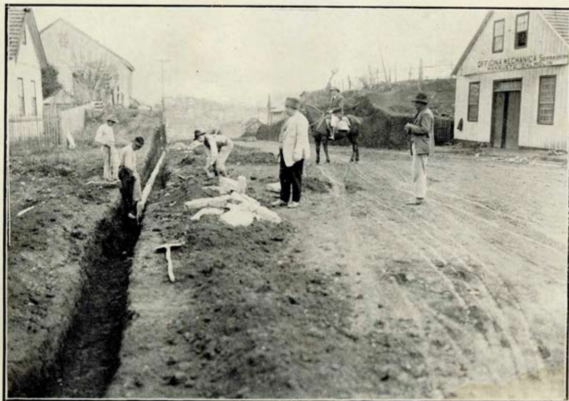
RUA SINIMBÚ — Assentamento de cordões.
