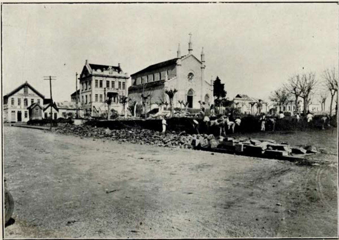
PRAÇA DANTE — Outro aspecto do trabalho de remodelação.
