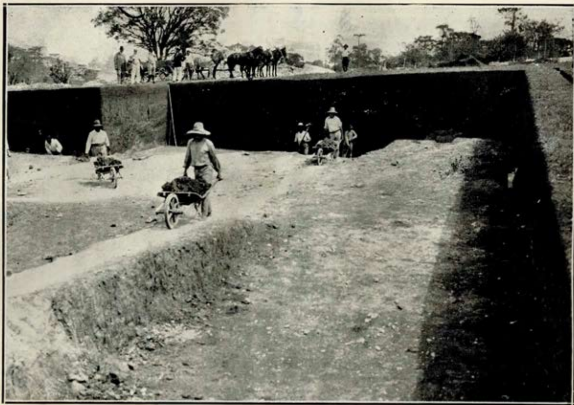
Início dos trabalhos no Reservatório N.º 1.
