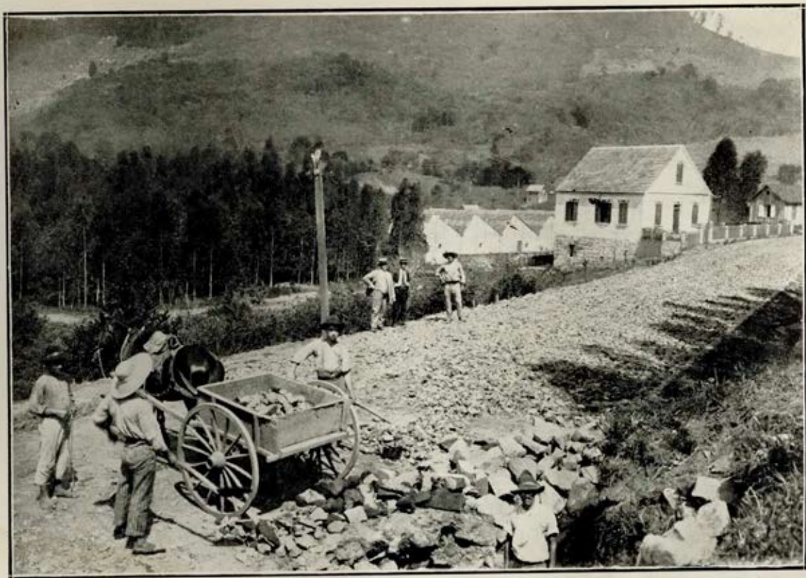
SÉDE DE GALLOPOLIS — Início dos trabalhos de macadamização.
