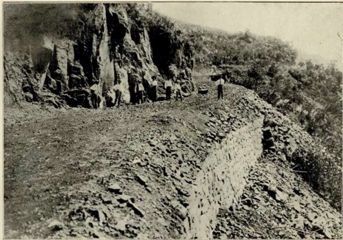
ESTRADA DO PIAHY — Muro de arrimo.
