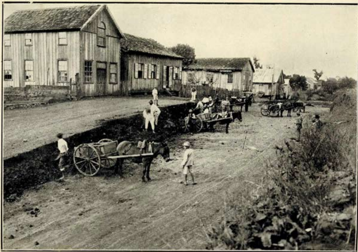
RUA ALFREDO CHAVES — Serviço de excavação.
