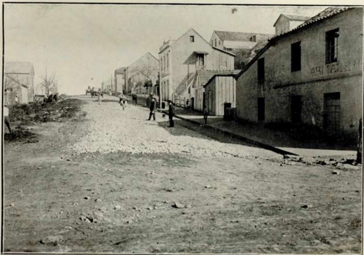
RUA GARIBALDI — Macadamização. Foi aterrada com a excavação da Praça Dante.
