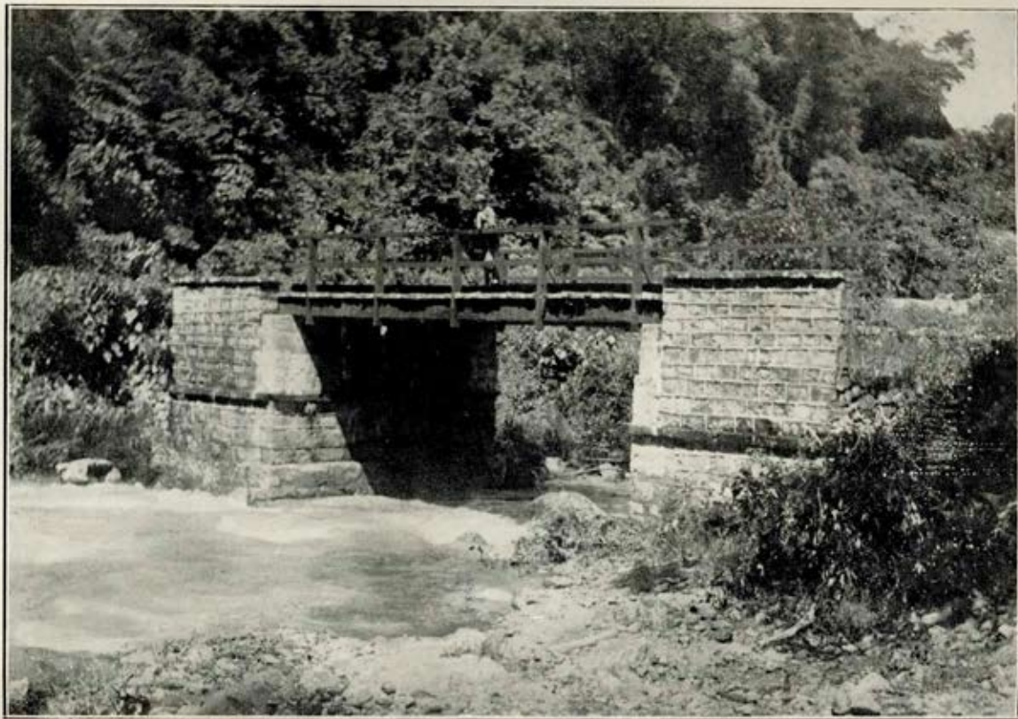
PONTE SOBRE O RIO PINHAL — Proximidades da divisa entre São Sebastião do Cahy e o districto de Gallopolis.
