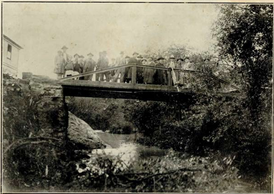
Ponte perto da officina Triches, na 9.ª legua 7-5-1927.
