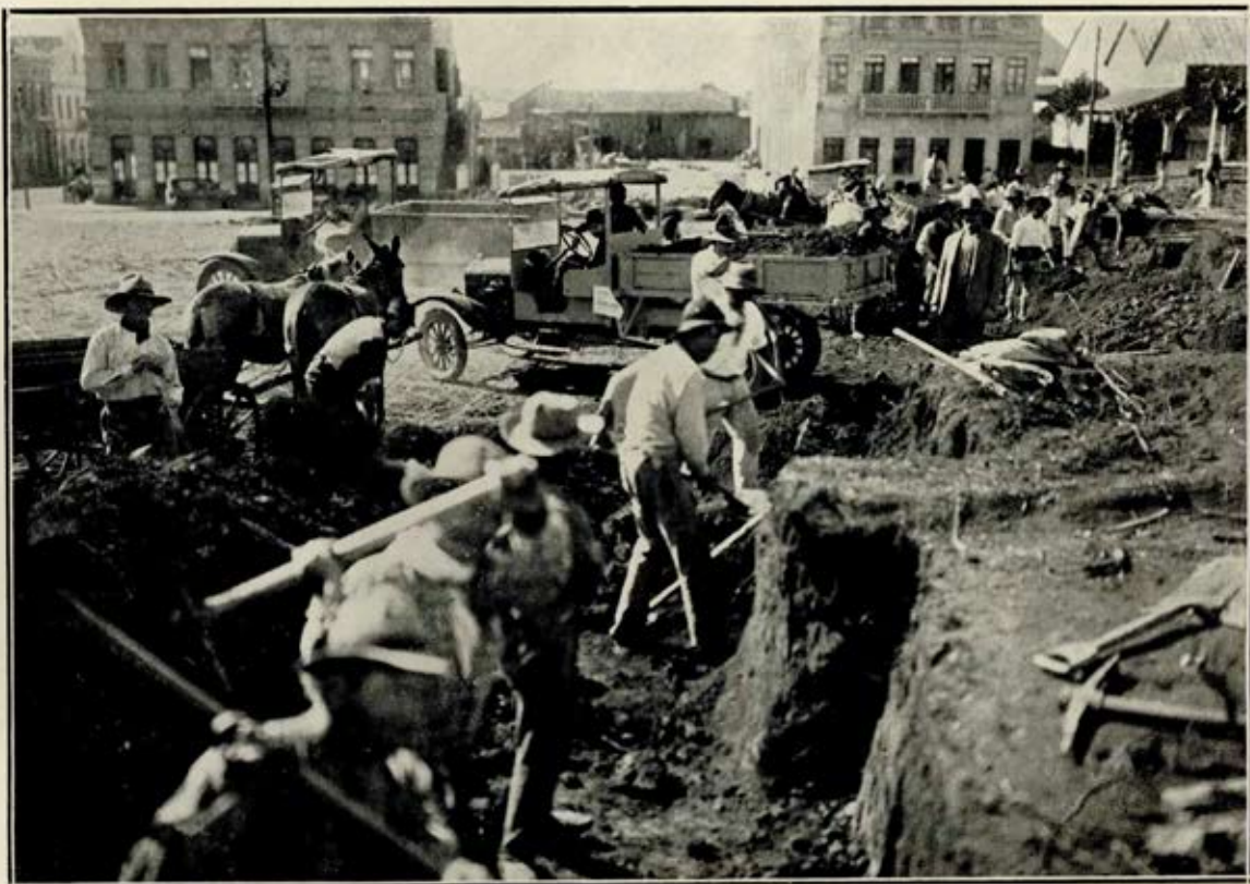
PRAÇA DANTE — Início dos trabalhos de remodelação.
