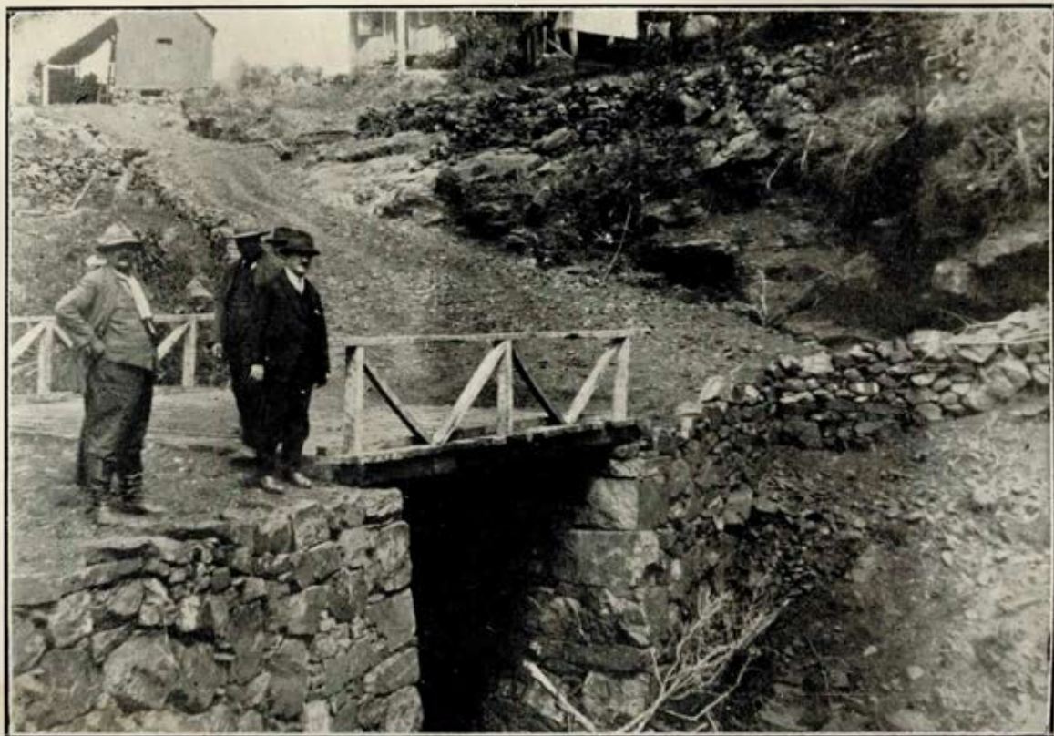
Ponte no trecho da mesma estrada nas OITO COLONIAS depois de executada uma ponte e a variante.
