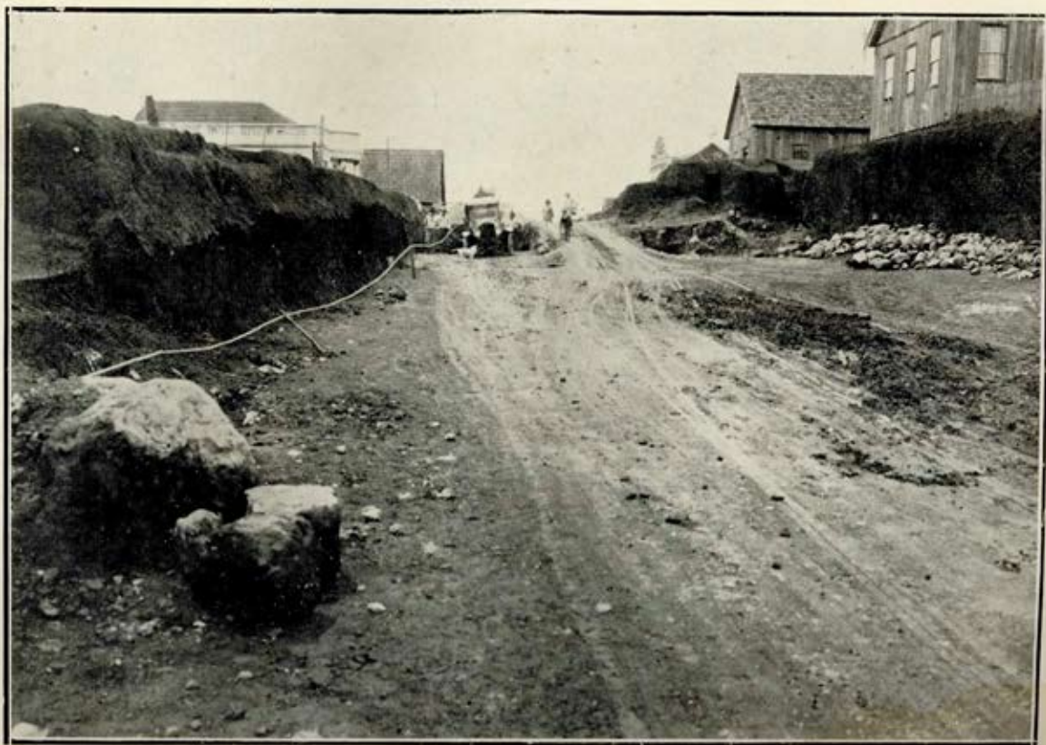
RUA SINIMBÚ — Trabalho de desaterro.
