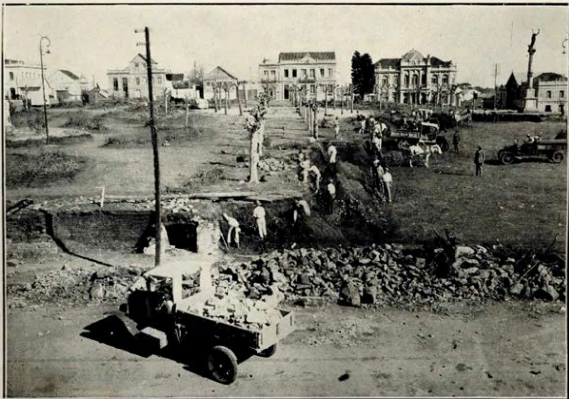
REMODELAÇÃO DA PRAÇA DANTE — O desaterro está servindo para diversas ruas nas proximidades.
