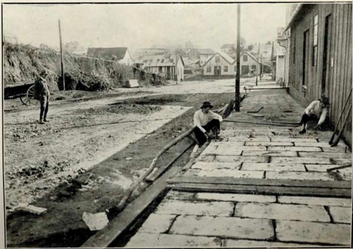
RUA ANDRADE PINTO — Assentamento de calçada.
