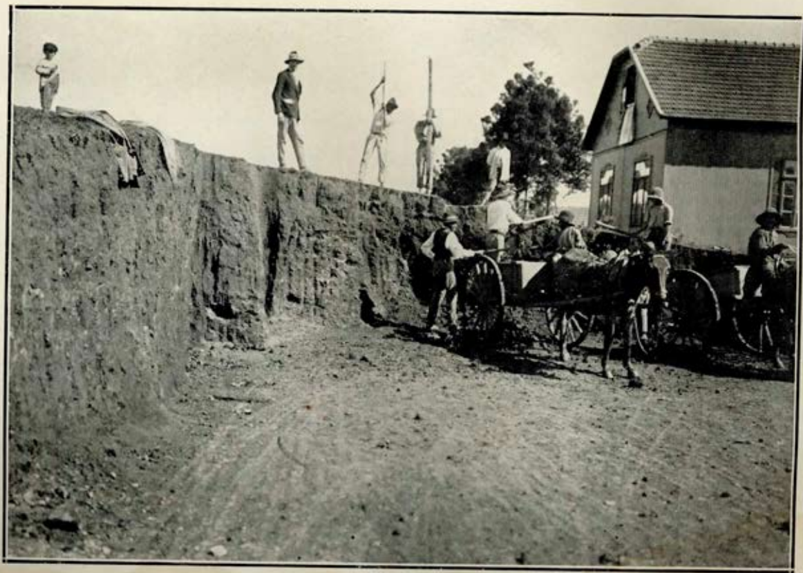
RUA PINHEIRO MACHADO — Trabalho de desoterro.
