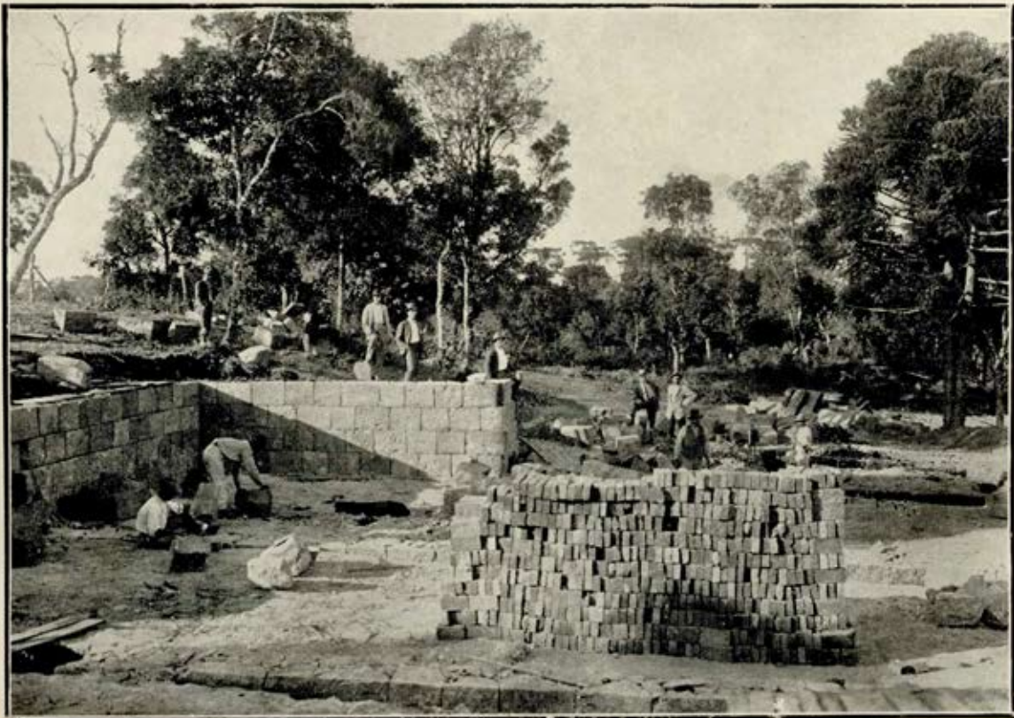
PATRONATO AGRICOLA — Início da construção.
