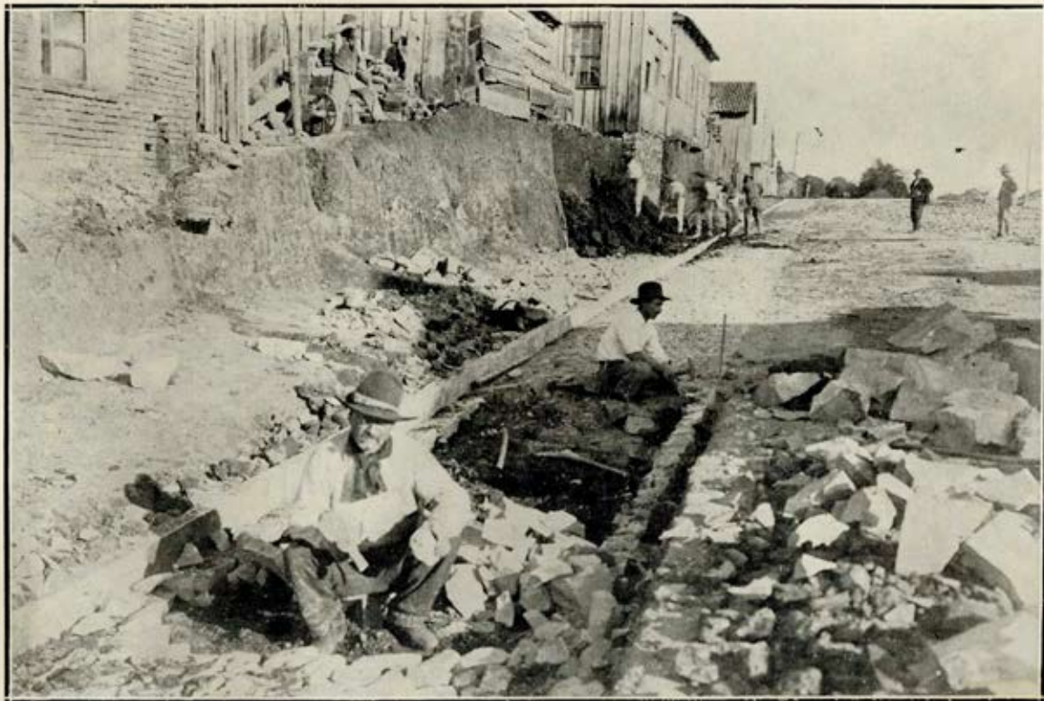
RUA ALFREDO CHAVES — Assentamento de cordões e sargetas.
