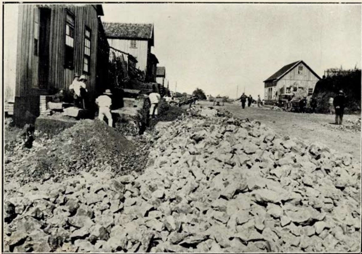
RUA ALFREDO CHAVES — Serviço de cordões, sargetas e macadam.
