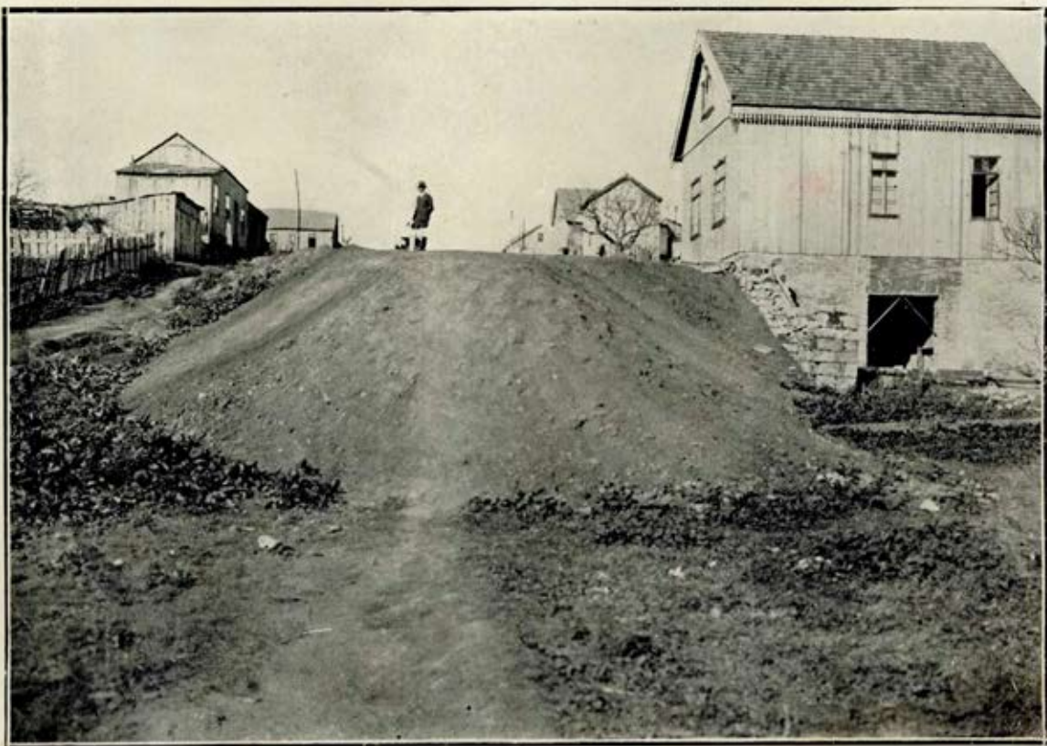
RUA SINIMBÚ — Serviço de aterro.
