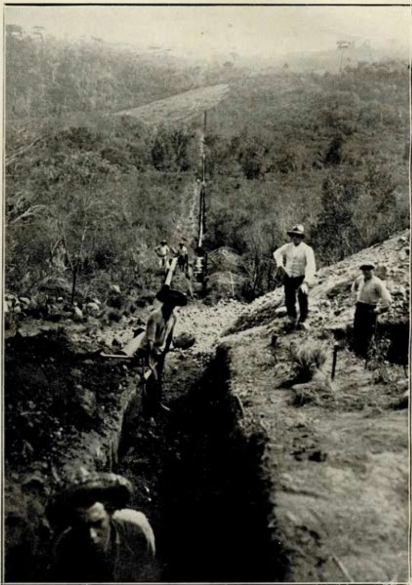
Assentamento da linha adductora da represa no Dal Bó.
