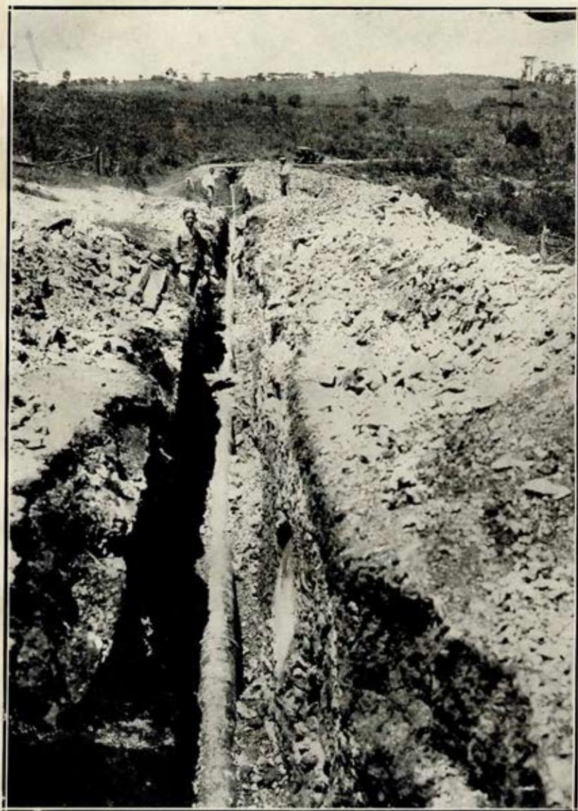
Assentamento da linha adductora "DAL BÓ"
