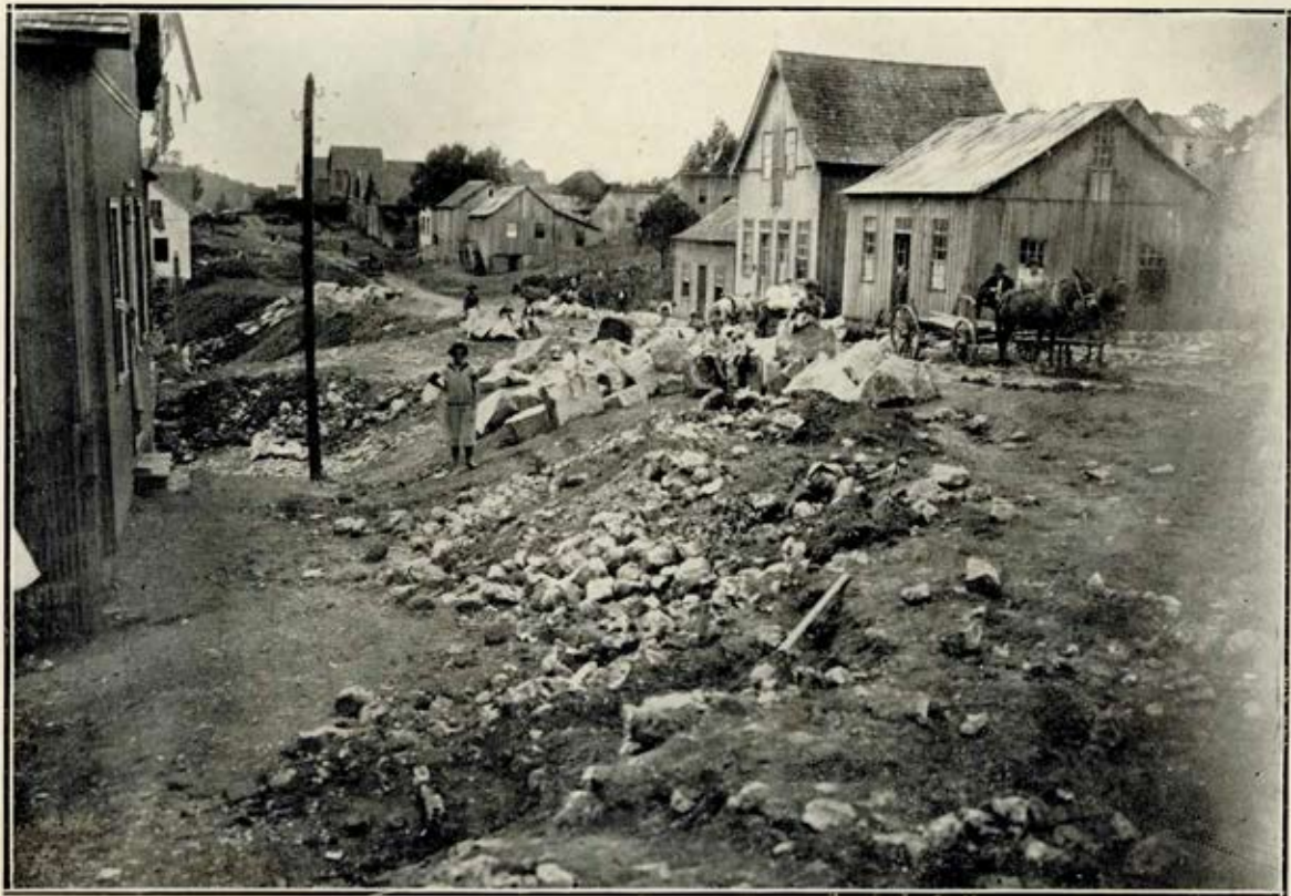
RUA SINIMBÚ — Trabalhos de systematisação do leito.
