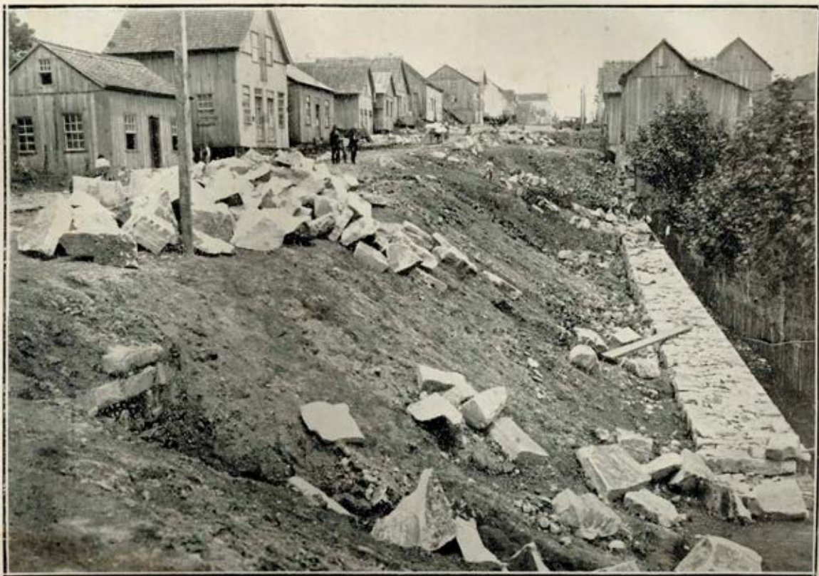
RUA SINIMBÚ — Trabalho de systematisação.
