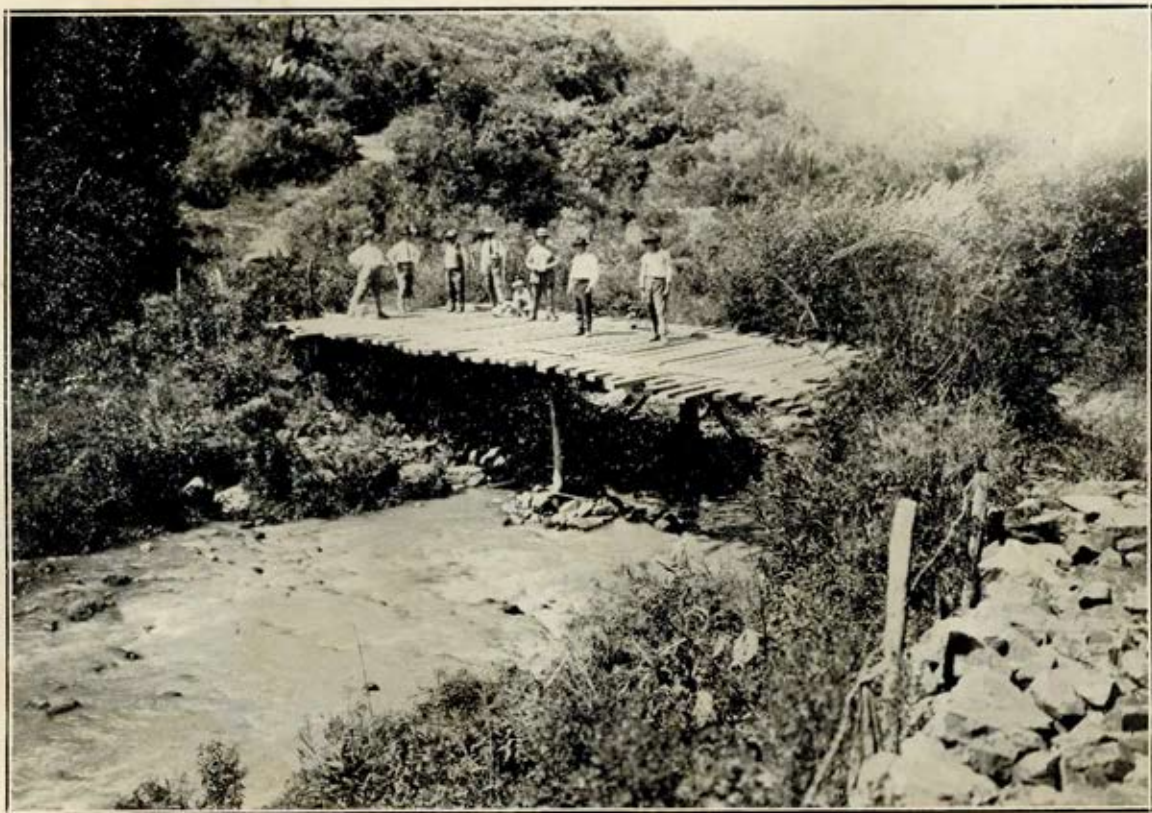
ESTRADA DO PIAHY — Ponte provisoria no Caravaggio.
