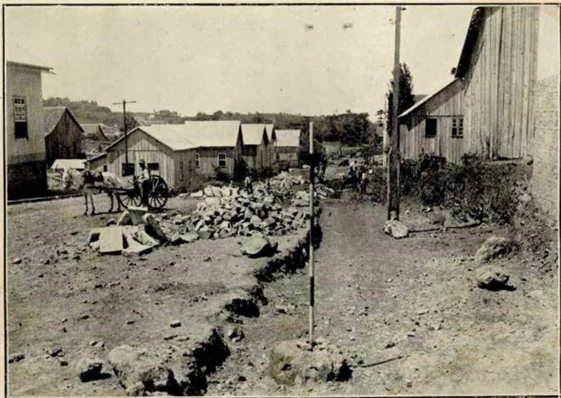
RUA MARECHAL FLORIANO — Preparação do Leito para assentamento de cordões e sargetas.
