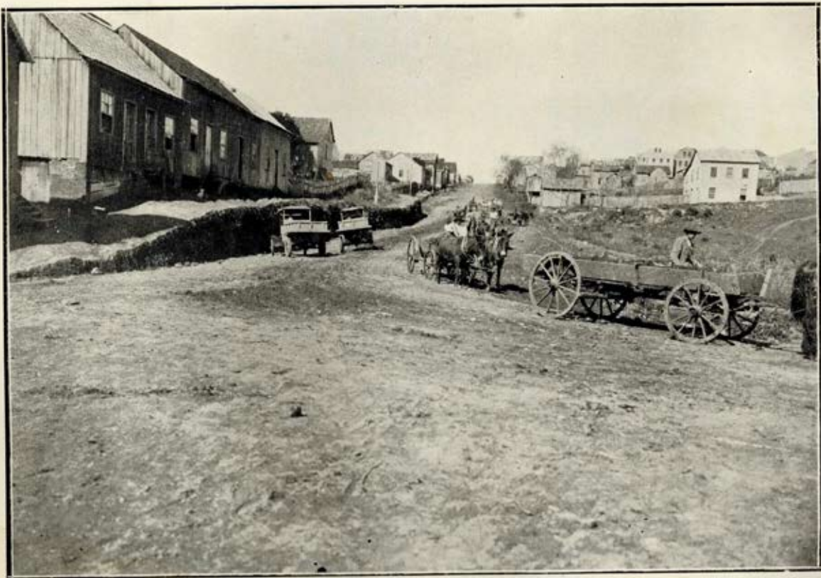
RUA DR. BORGES DE MEDEIROS — O aterro é tirado da Praça Dante em construção.
